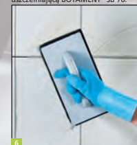
6 Spoinowanie płytek za pomocą wielofunkcyjnej zaprawy do spoin MULTI-FUGE® Schmal.
