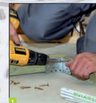
1 Wykonaj oraz odpowiednio wzmocnij konstrukcję nośną, a następnie połącz ją z podłożem.
