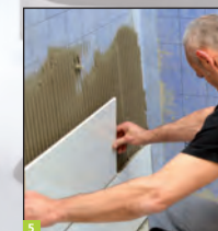
5 Po wyschnięciu uszczelnienia nanieś zaprawę klejową BOTAMENT® M 21 za pomocą pały zębatej i przystąp do montażu płytek.
